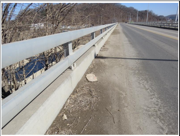
난간 및 연석 전경
