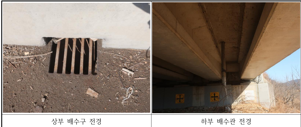
【그림 1.59】대전교 배수시설 현황
